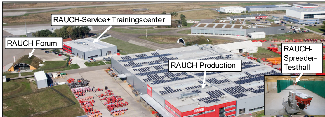
Bild 18: Der neue RAUCH-Produktionsstandort mit Service- und Trainings-Center am Baden-Airpark in Rheinmünster. Rechts unten: die neue, 2019 eingeweihte Düngerstreuertesthalle, etwas entfernt vom Werk [RAUCH Landmaschinenfabrik GmbH]
